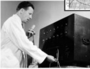
Czasomierz elektrony służy do mierzenia szybkości pocisków (1959r.)
